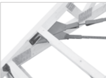
Detail am Traufpunkt: Bandanschluss BNG25 mit Kopplungsverbinder BNKK25 auf der Oberseite des Untergurtes und dem Spanngerät BNSP25 auf der Unterseite des Obergurtes.
