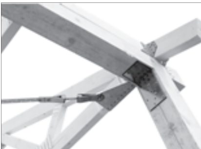
Detail am Traufpunkt: Bandanschluss BNF25 mit Spanngerät BNSP25 auf der Unterseite des Untergurtes befestigt.
